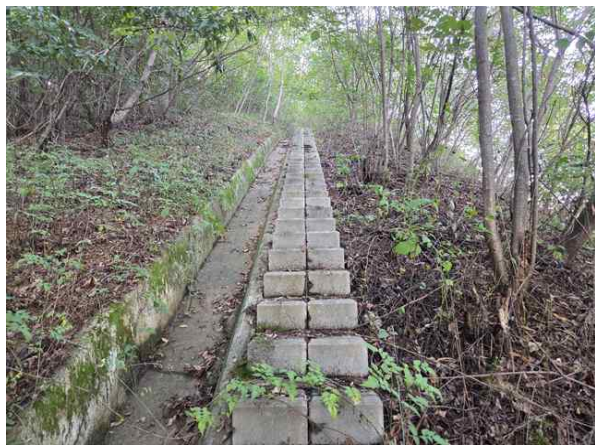
산마루측구, 점검계단 전경
